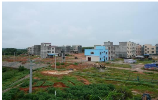
图 20 建设中的新村远景（2009 年）
