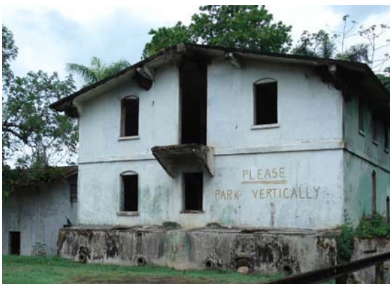
Fotografía 16: Otra vista de la Potabilizadora de aguas
