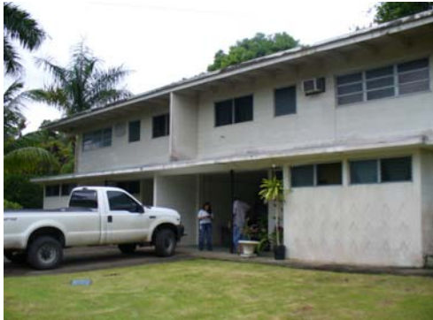
Vista de la vivienda 507 B, donde el propietario tiene 30 años de residir en ella.
