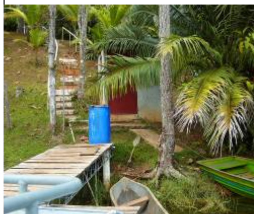
La Arenosa. Muelle – Toma de Agua
