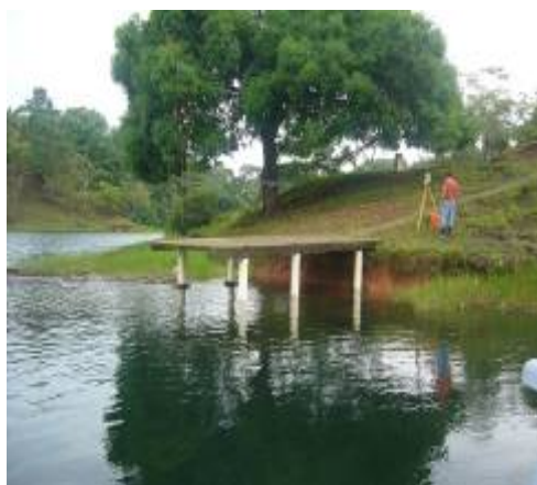
Limón, Muelle comunal elevación 27.1 m
