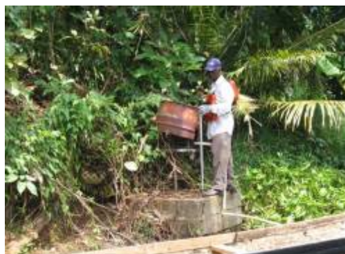
Cuipo, Toma de agua elevación 26.5 m
