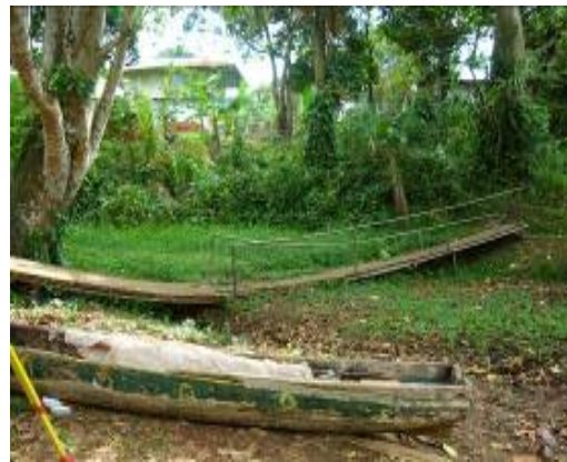
Escobal, Puente peatonal elevación 26.7 m
