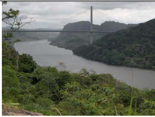
Foto 5-4 Vista del Corte Culebra. Mendieta, 2004.
