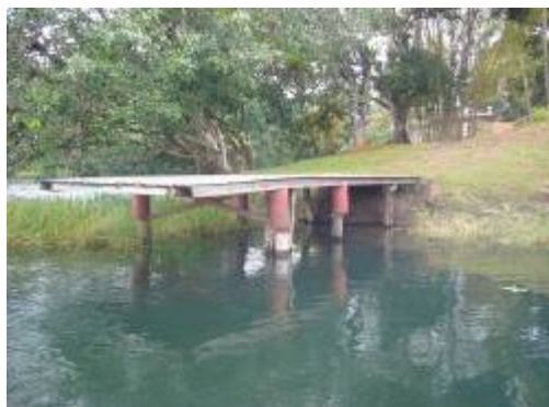
Nueva Providencia, Muelle elevación 26.8
