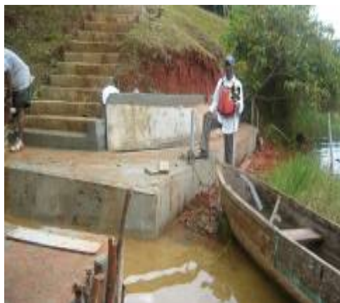
Nueva Providencia, Muelle elevación 26.5 m
