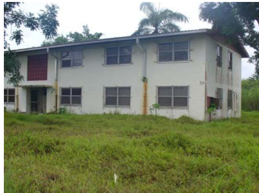
Vista de una de las viviendas desocupadas
