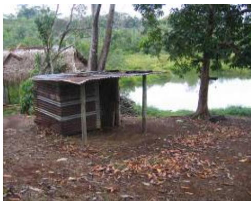
Los Laguitos, Depósito elevación 26.7 m
