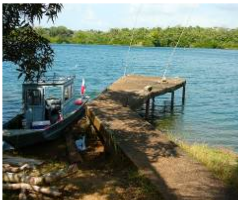
La Leona, Muelle elevación 26.9 m
