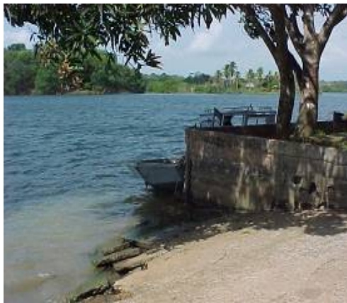
Lagarterita, Muelle elevación 26.3 m
