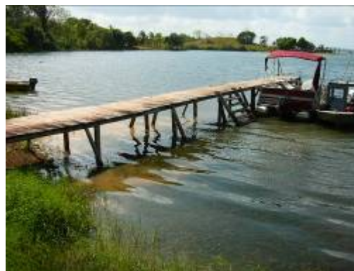
La Leona, Muelle elevación 27.1 m
