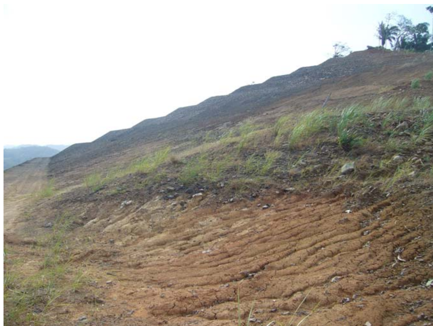
Foto 2: Vista General de Talud Expuesto en el Corte Culebra mostrando signos de Erosión Hídrica Laminar y en Surcos. Fuente: Gira de Campo EIA Ampliación del Canal (marzo 2,007).
