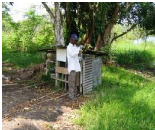
Cuipo, Iglesia Cuadrangular, Toma de agua elevación 26.64m
