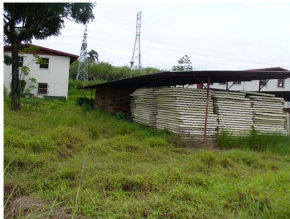
Sitio de depósito de materiales de construcción utilizado por el MIVI de Colón
