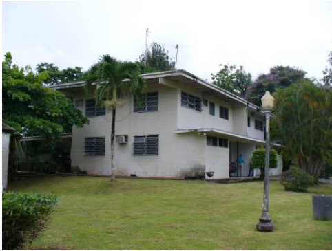
Vista lateral de la vivienda 502A y 502 B
