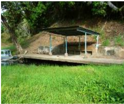
Escobal, Muelle elevación 26.7m
