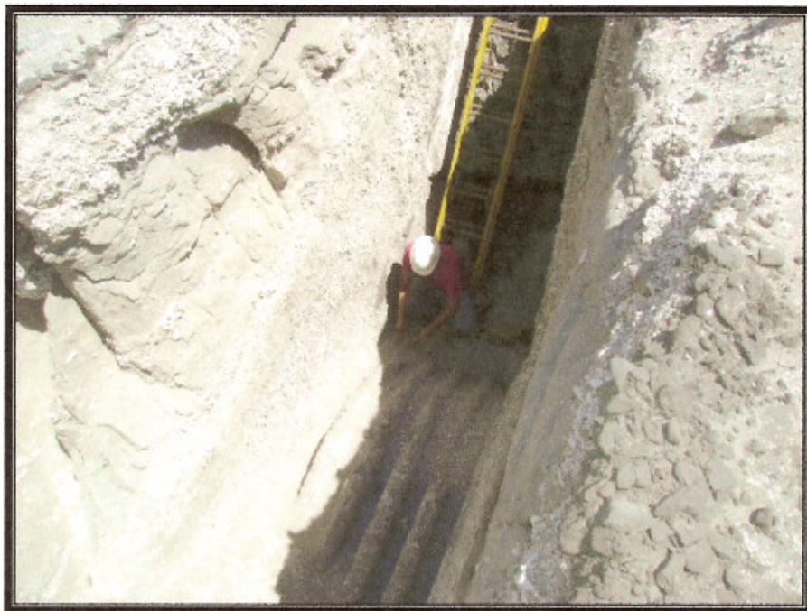
Fotografía N° 3: Vista pared y fondo de calicata.
