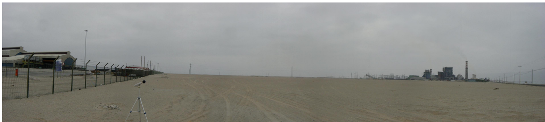
Foto RU-4 Punto de medición N° 4
