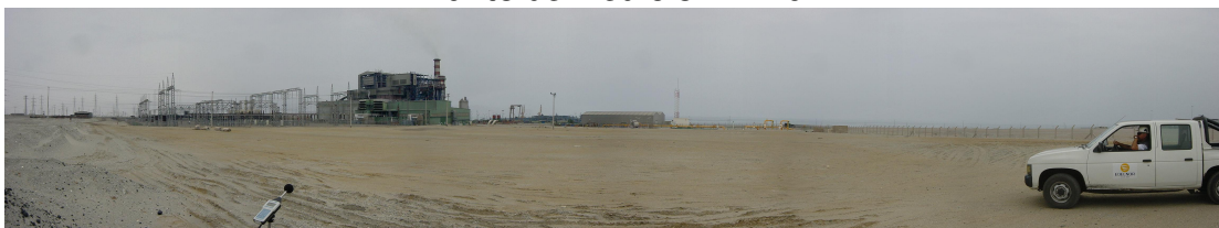
Foto RU-10 Punto de medición N° 10
