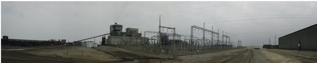
Foto RU-9 Punto de medición N° 9
