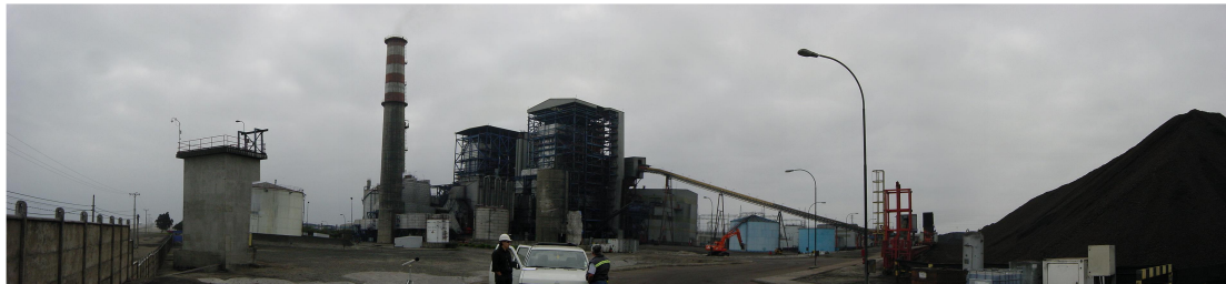
Foto RU-8 Punto de medición N° 8
