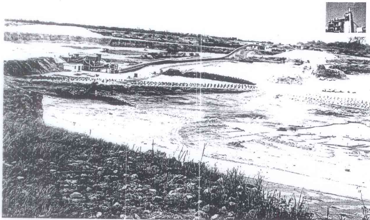
Image N°2 : Bande transporteuse reliant le concasseur à l'usine (en médaillon).
