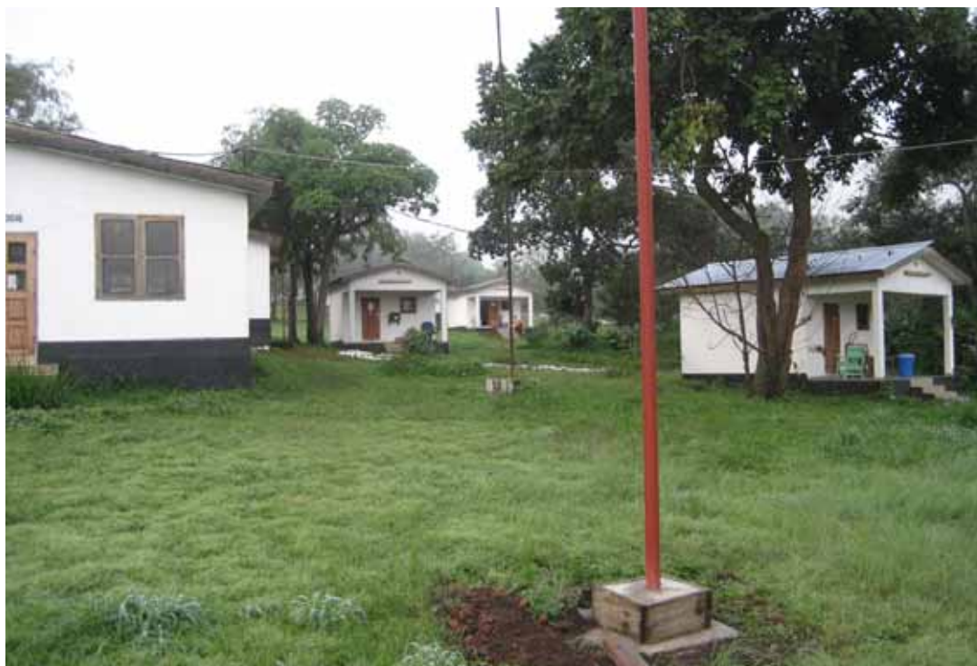
Photo 7 Infrastructures existantes au camp de Canga Est
