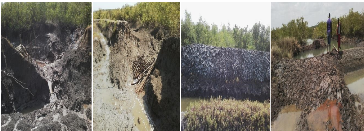
Digues de protection avant aménagement
