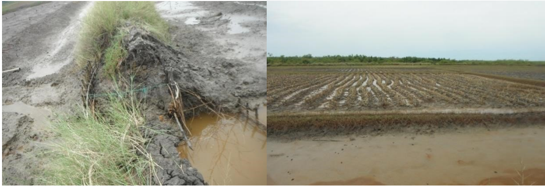
Conséquences de la remontée saline du 17 septembre : digue cassée et production détruite
