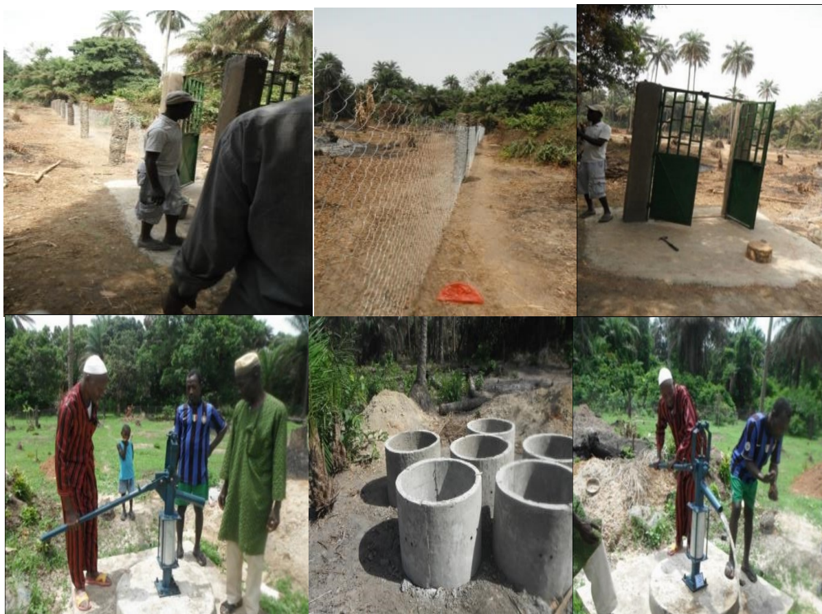
Domaine maraîcher aménagé et sécurisé en clôture grillagée
