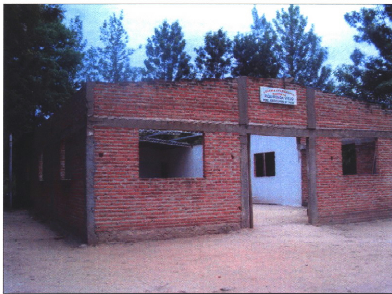
Foto 3. Portada de la Iglesia Evangélica en construcción en el momento de la visita a la Misión Piquirenda.
