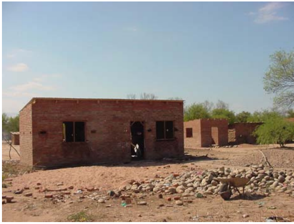
Construcción viviendas : Capirendita, Comunidad indígena Weenhavék
